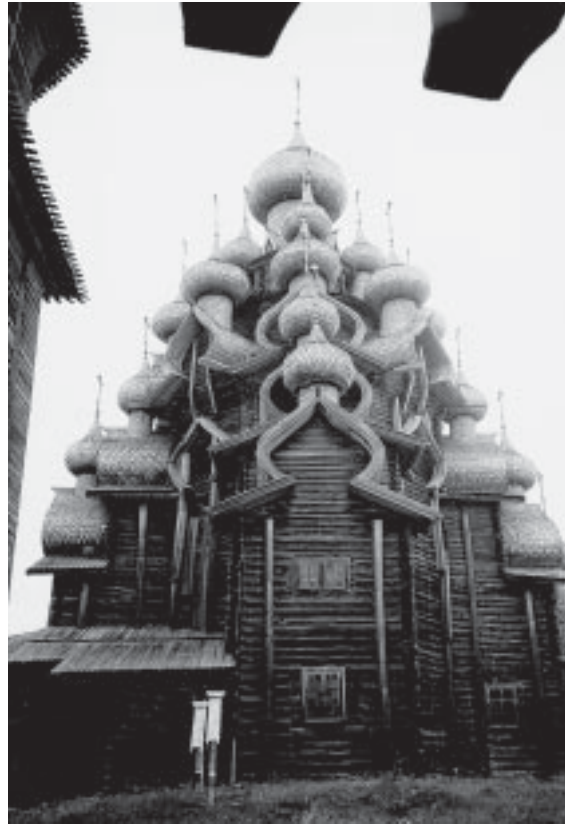
Holzkirche, ohne Nägel gebaut, im Onegasee bei Petrosawodsk/Karelien
